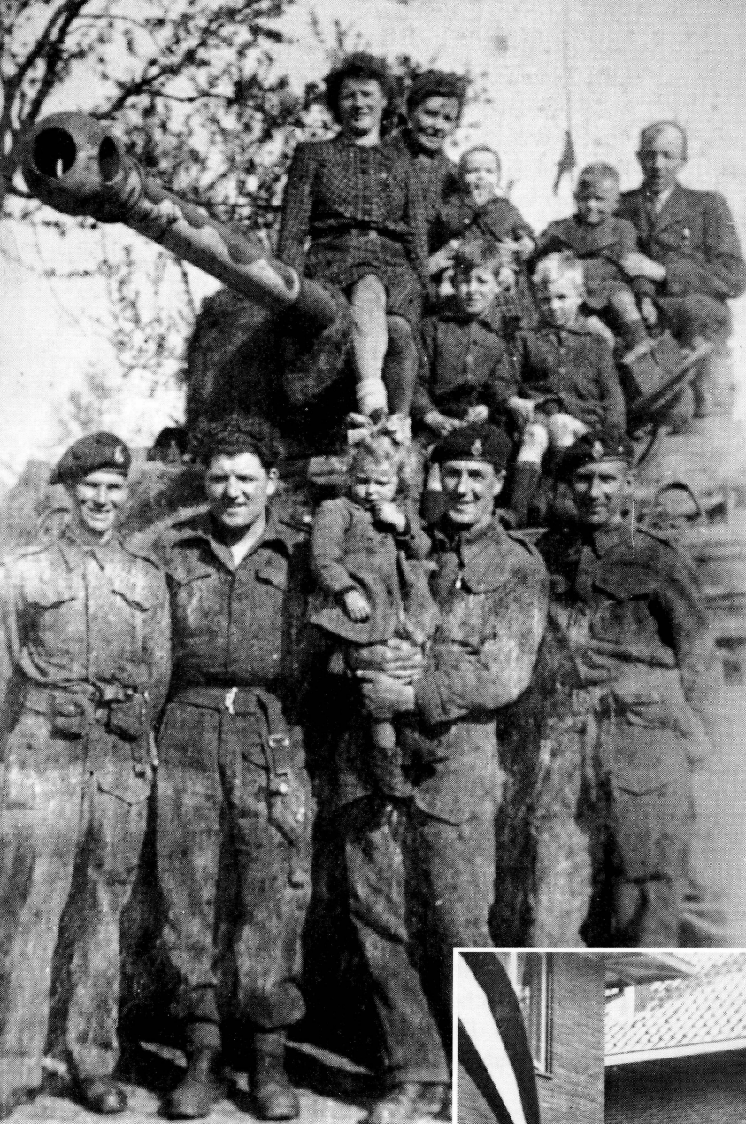
■ Oldenzaalsestraat met tank van C-eskadron Sherwood Rangers
